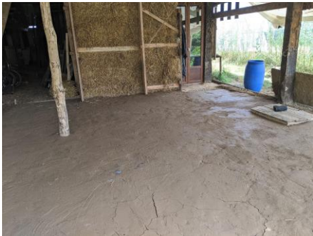
c) Hangar en cours d'aménagement, murs en terre/paille, dalle en terre crue
