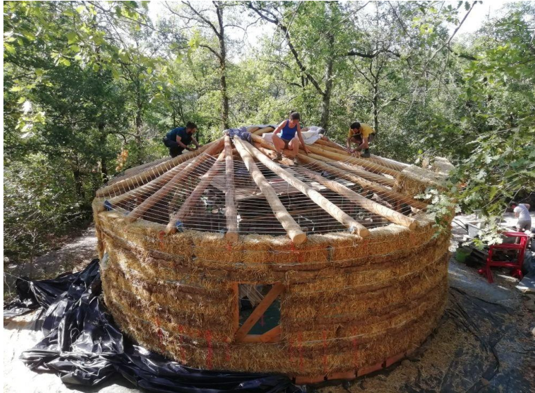
Figure 10 : un exemple de chantier participatif pour la construction d'une yourte en paille.
