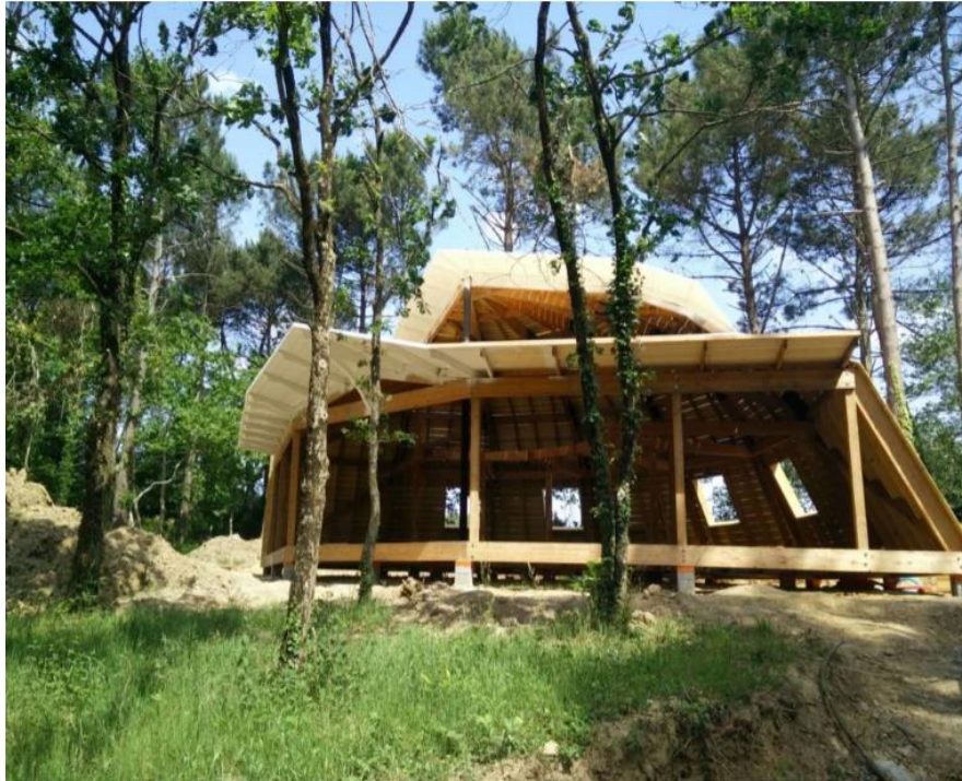
Figure 14 : Une maison autonome en cours de construction
