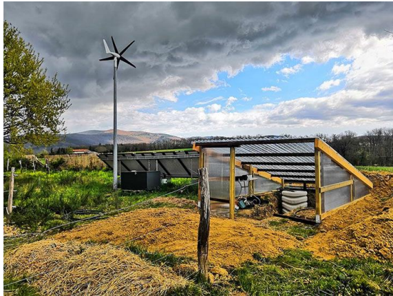
Figure 5 : Photo des panneaux solaires, de l'éolienne et de la serre de Brian
