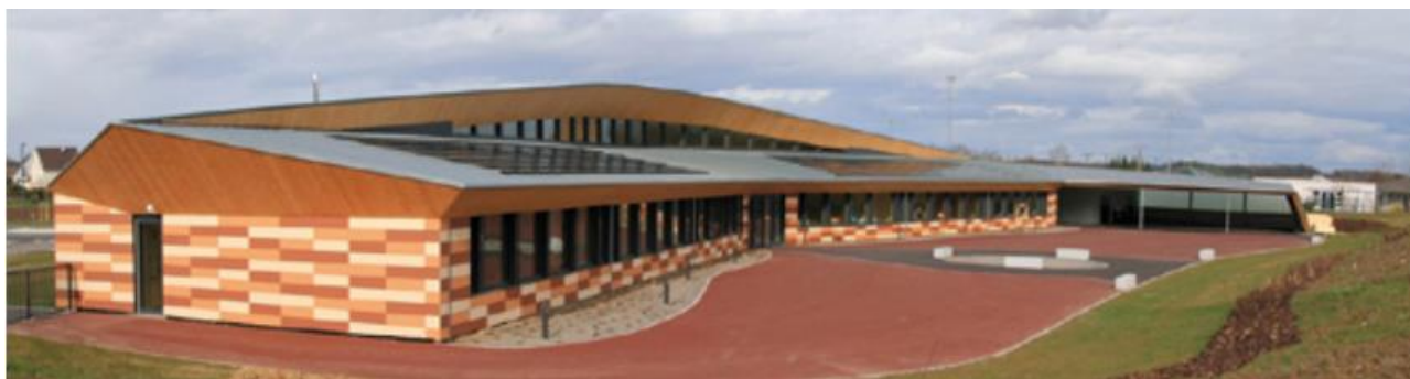
Vue d'ensemble de l'école de Burnhaupt-le-Haut
